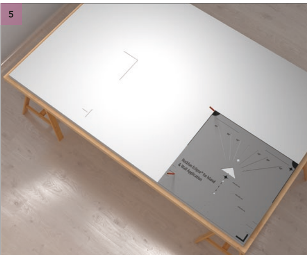
Umieść narzędzie do znakowania w prawym dolnym rogu z tyłu panelu Rockfon Eclipse Wall. Zaznacz ołówkiem osie, używając lewego górnego rogu narzędzia do zaznaczania oraz położenie uchwytu dystansowego.
