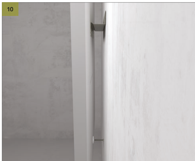
Zawieś panel Rockfon Eclipse Wall na ściennym profilu montażowym i wyreguluj uchwyty dystansowe, aż panel Rockfon Eclipse Wall zostanie wypionowany.
