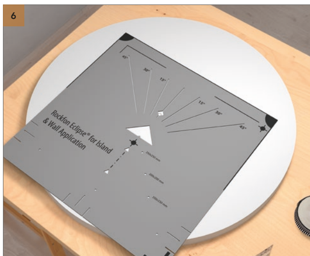
Ustaw narzędzie do znakowania tak, aby linie z kroku 5, narysowane wokół podstawy trójkąta narzędzia do znakowania, były idealnie wyrównane w wycięciu w kształcie rombu. Patrz 6 - Szczegół.
