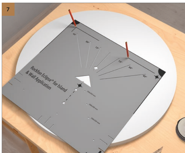
Zaznacz linie, w których należy umieścić profil montażowy panelu. Patrz punkt 7 - Rezultat.
