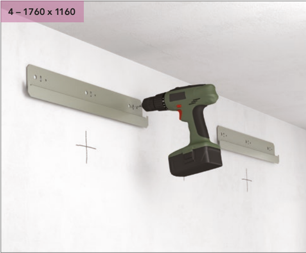
Wywierć otwory i zainstaluj profil montażowy do ściany.
