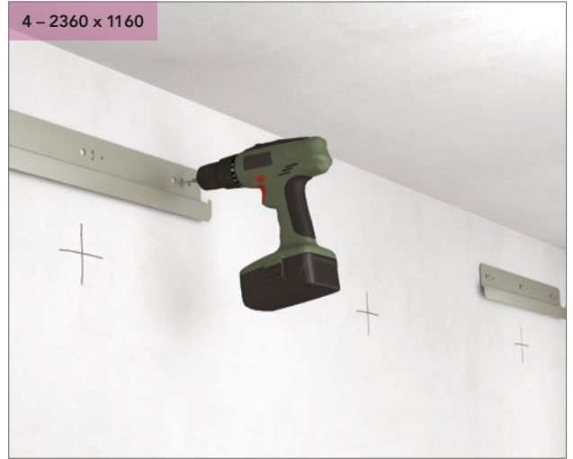
Wywierć otwory i zainstaluj profil montażowy do ściany.
